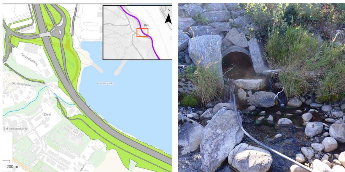
Figur 4-15. Bekk ved Diset. Bildet til høyre er fra kulvertens utløp ved Paradisvika, under befaring 5. september 2022. Kilde: COWI AS
