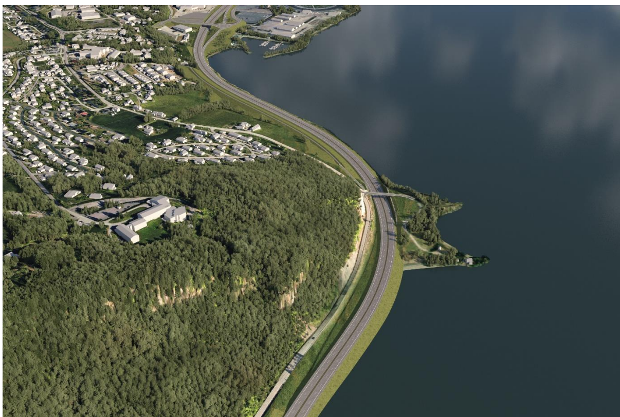
Figur 4-10. Veifyllinger ut i Mjøsa sør for Kremmerodden og innerst i Paradisvika (øverst til høyre i figuren). Krapp kurvatur forbi Kremmerodden, og geotekniske forhold, krever fyllinger og masseutskifting i områdene. Fyllingen sør for Kremmerodden er større for å avgrense tiltak i Paradisvika mest mulig. Tursti er planlagt innenfor ny E6, for å unngå større utfylling i Mjøsa. Kilde: COWI AS
