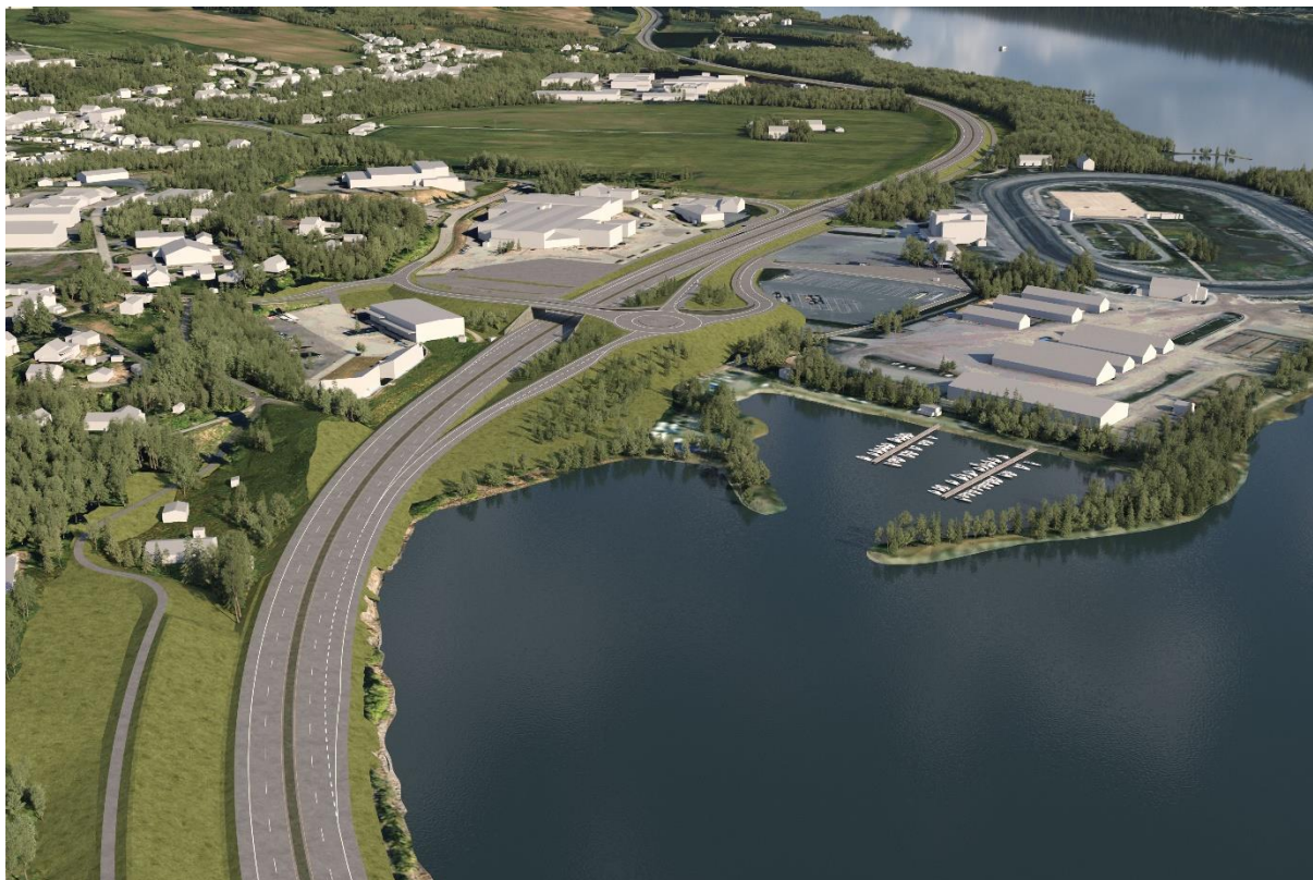
Figur 4-11. Veifyllingen i Paradisvika har blitt begrenset så mye som mulig, uten å endre på vegstandard. Tursti er planlagt innenfor ny E6, og avkjøringskrysset i Biri er planlagt nord for Paradisvika. Kilde: COWI AS
