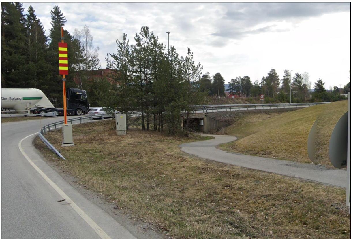
Figur 1: Dagens undergang ved Vertshuset i Biri, sett mot Travbanen. Kilde. Google
