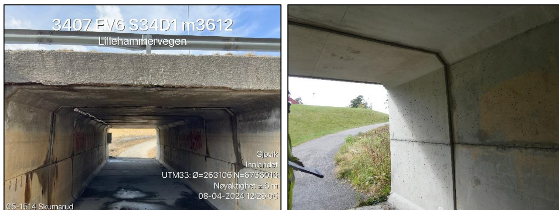
Figur 4: Tilstandsbilder. Kilde: Brutus
