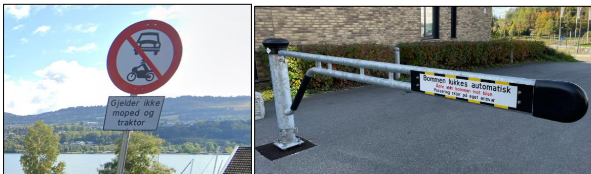
Figur 2-13: Tiltak for å hindre ulovlig kjøring med skilting og bom.
