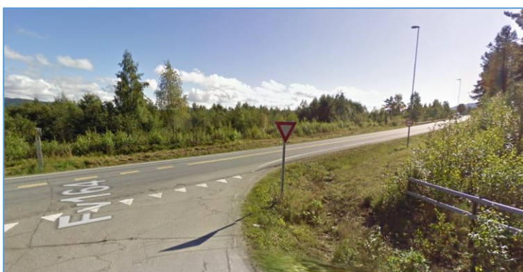
Figur 3-10: Kryssområdet fra fv. 2418 mot rv. 4 retning sør i 2010. Sikten er ryddet siden dette bildet er tatt. (Kilde: Google Maps Street View)
