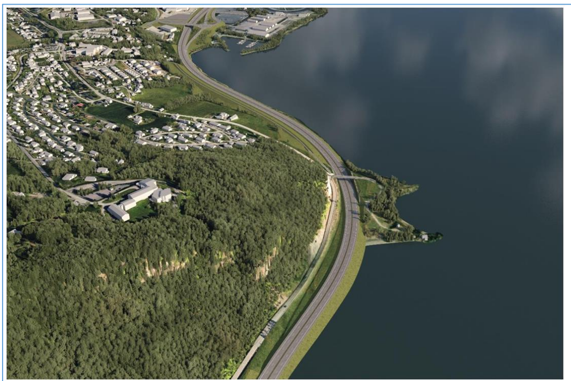
Figur 3. Veifyllinger ut i Mjøsa sør for Kremmerodden og innerst i Paradisvika. Krapp kurvatur forbi Kremmerodden og geotekniske forhold krever fyllinger og masseutskifting i områdene. Fyllingen sør for Kremmerodden er større for å avgrense tiltak i Paradisvika mest mulig. Tursti er planlagt innenfor ny E6, for å unngå større utfylling i Mjøsa. Kilde: COWI AS.
