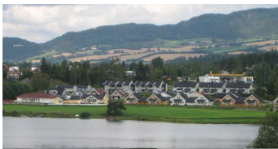
Bebyggelse i strandsonen som bryter vegetasjonsbeltet, men som er klart avgrenset. Strandsonen er åpen for allmenn ferdsel. Takflatene er mørke. Veggflatene burde hatt mørkere naturfarger.
