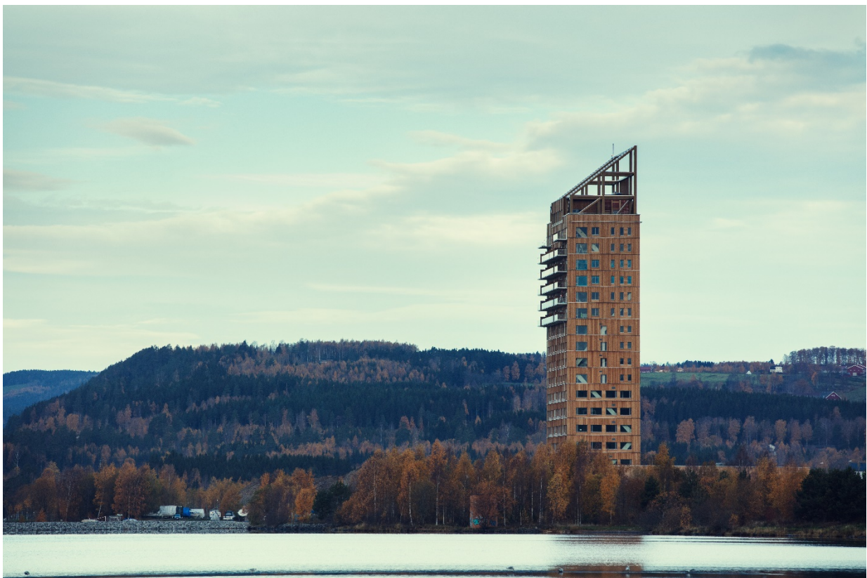
Mjøstårnet, verdens høyeste trebygning, sett fra sjøsiden. Foto: ANTI Hamar
