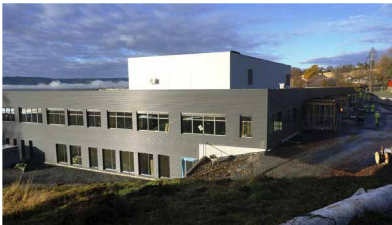
Nye Brøttum barne- og ungdomsskole ble bygd. I oktober nærmet bygget seg ferdig.
