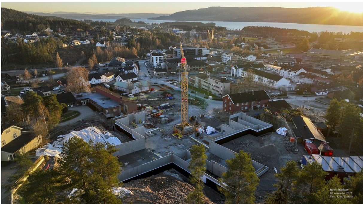
Nye Moelv sykehjem under oppføring.
